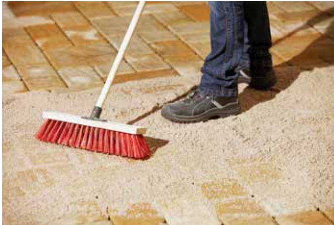
Gartenfreunde profitieren von der einfachen Systemlösung: Nach dem Auftrag des Fugensandes genügt es, die Reste mit einem Besen wegzufegen. Ein gepflegter Außenbereich lädt anschließend zum Entspannen und Genießen ein. (Foto/Grafik: epr/Buschbeck)
